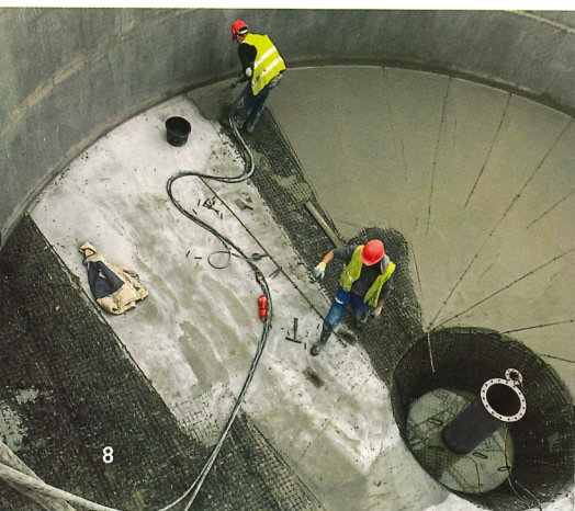
ČOV Tanvald při opravách
