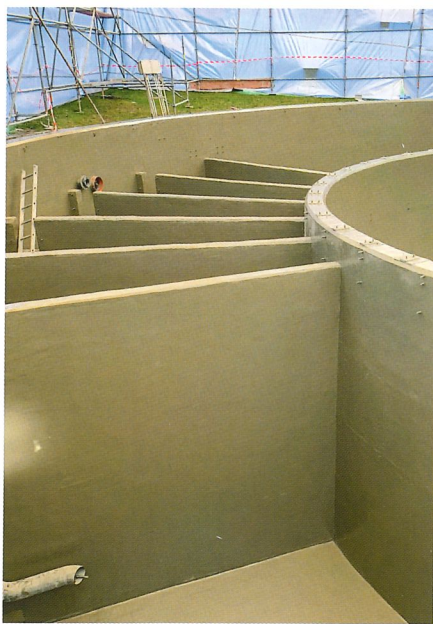
ČOV Tanvald po opravě
